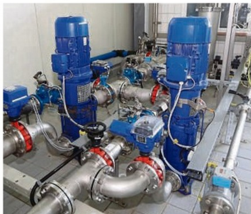
In dieser Anlage wird in Germerode aus Wasserkraft Strom erzeugt.
